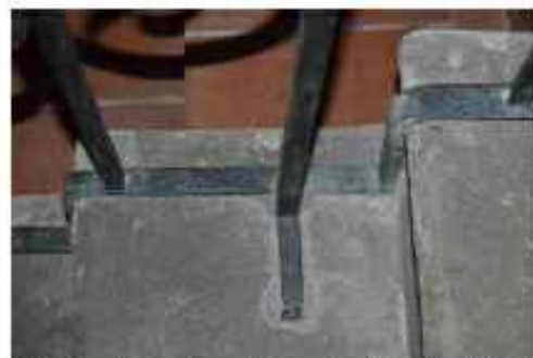
detail kotvení zábradlí do stupňů schodiště
