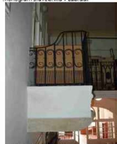
zakoření čela pavlače
